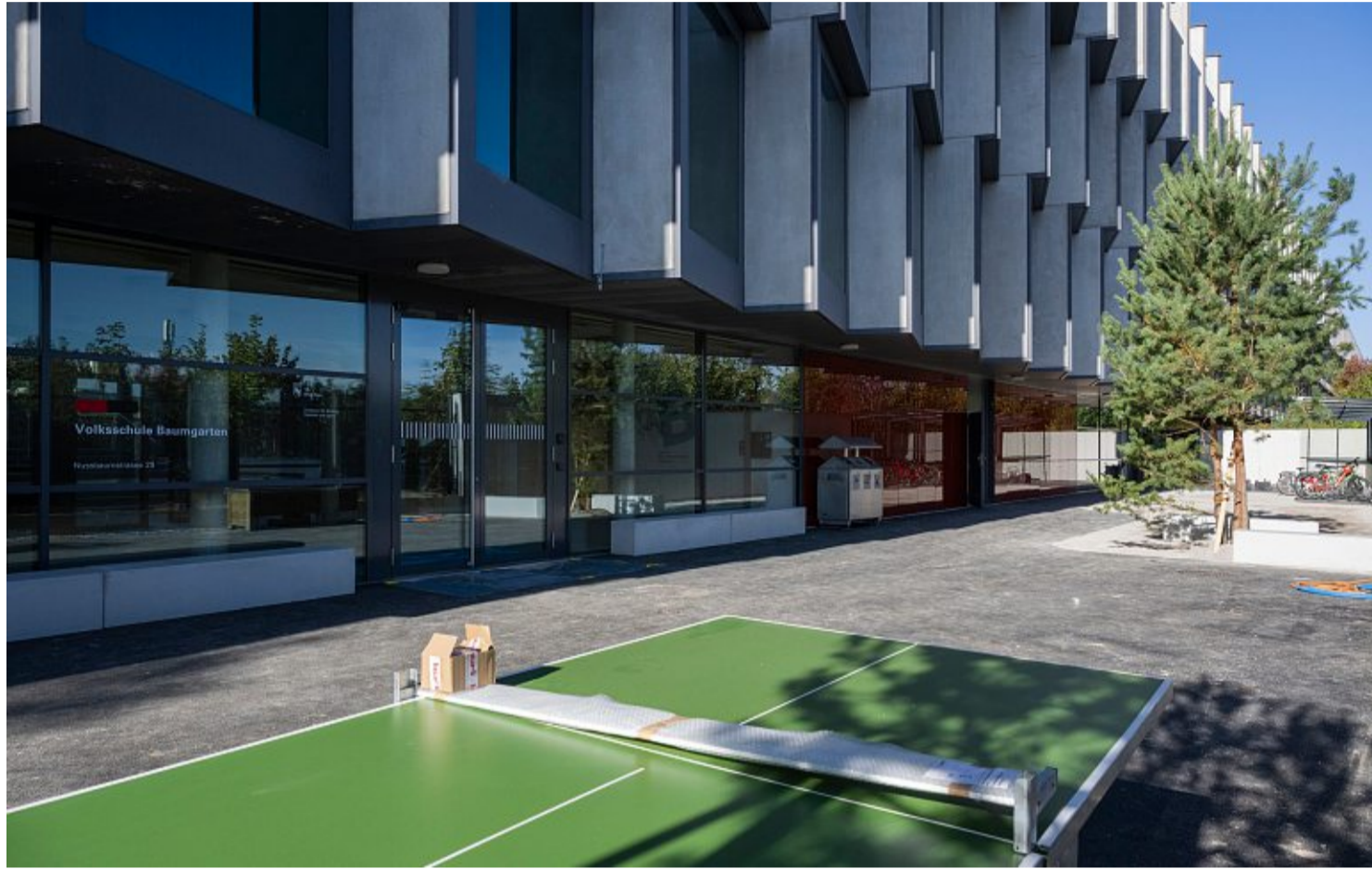
Nur wenige Tage vor Schulbeginn nach den Herbstferien wurde am Schulhaus Baumgarten noch gearbeitet. Foto: Raphael Moser
