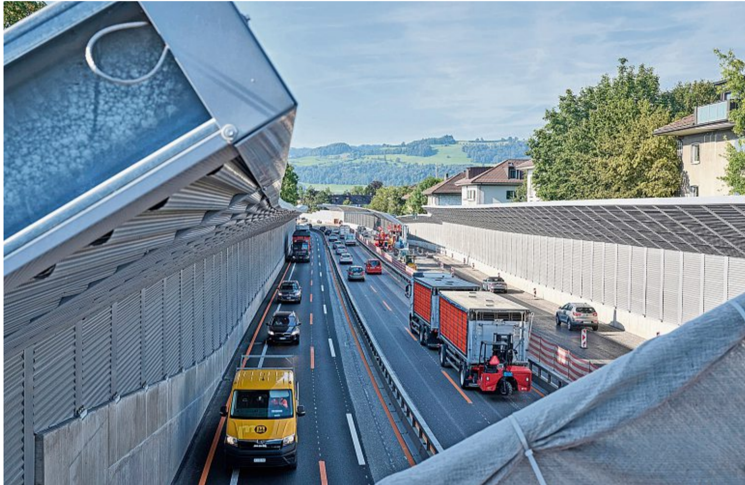
Die Autobahn im Ostring soll zurückgebaut und bis ins Jahr 2045 durch einen Tunnel ersetzt werden. Foto: Adrian Moser
