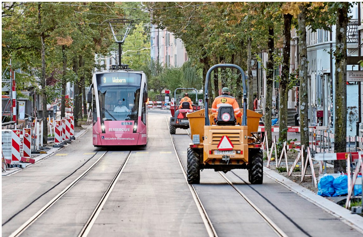
Das Nünitram fährt wieder durch das Breitenrainquartier. Nach wie vor sind jedoch Baumaschinen im Einsatz. Foto: Adrian Moser
