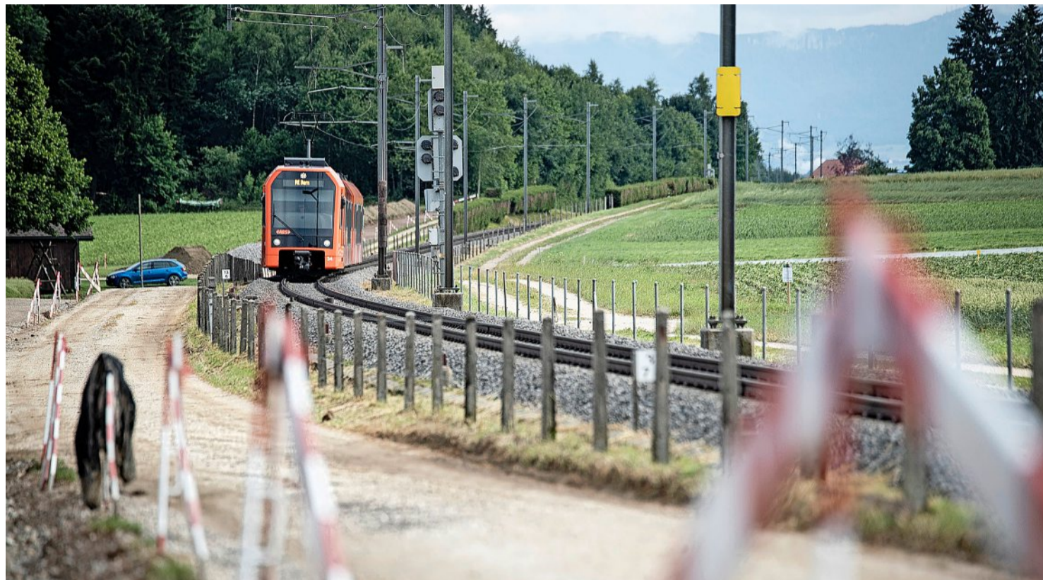
Dieser Streckenabschnitt bei Büren zum Hof in Richtung Schalunen wird auf Doppelspur ausgebaut. Foto: Nicole Philipp
