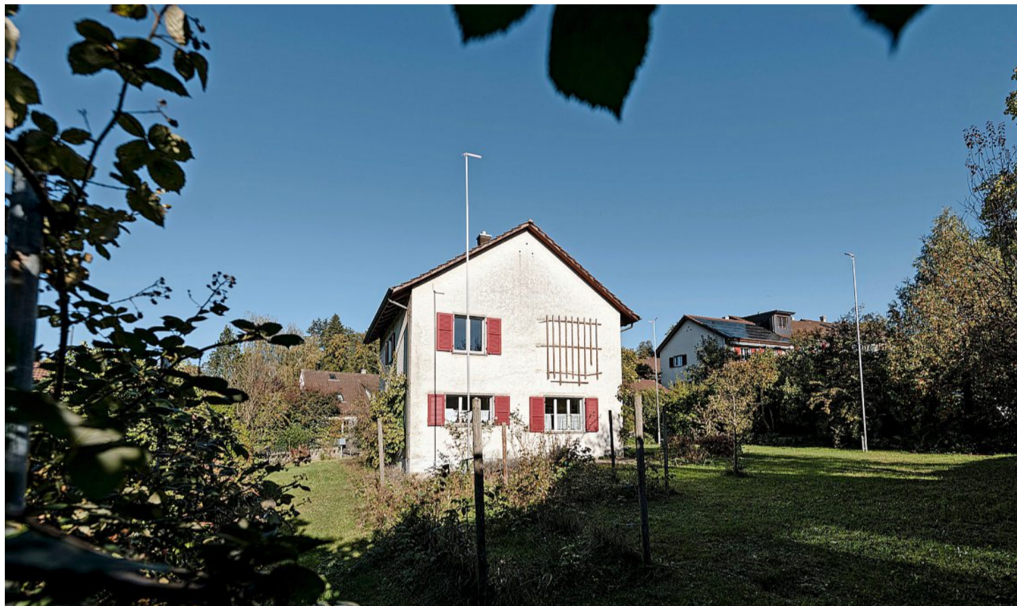
Die Anwohner im Stadtberner Wylerdörfli fürchten, vom Neubau am Pillonweg 1 buchstäblich in den Schatten gestellt zu werden. Foto: Susanne Keller
