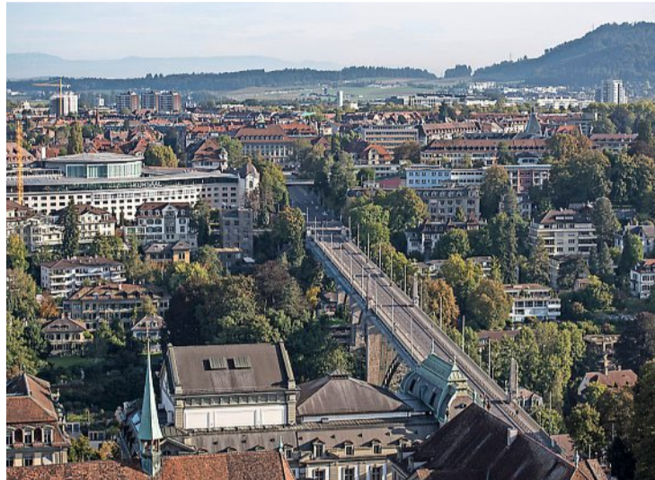
Ab 5. Juli wird im Breitenrainquartier gebaut und saniert: Kornhausstrasse und Viktoriaplatz sind gesperrt. Foto: Alessandro Della Valle (Keystone)
